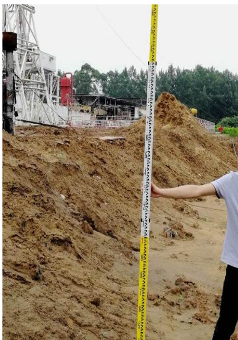
图 4-8 自 201H5 平台钻井工程堆土场
