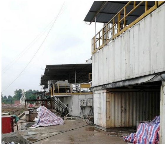
井场 (挖损损毁程度: 重度)
