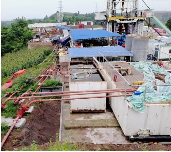
井场 (挖损损毁程度: 重度)
