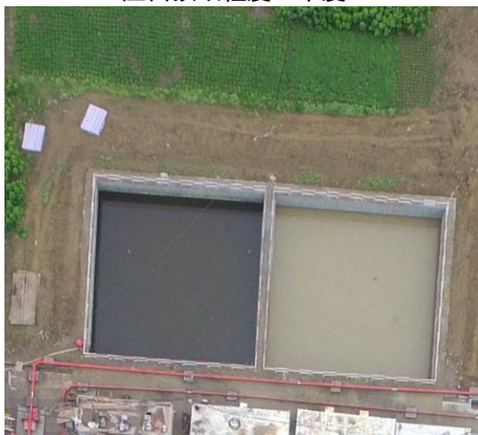
应急池 (挖损损毁程度: 重度)
