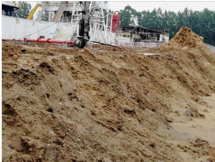
图 4-2 自 201H5 平台已损毁土地剥离表土保存现状（堆土场）
