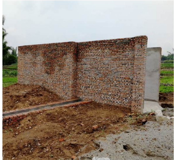
放喷坑 (挖损损毁程度：重度)
