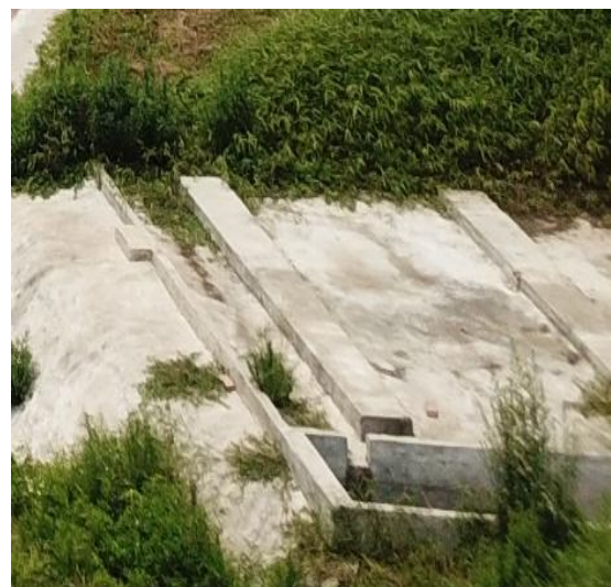
油罐及水罐（重度）
