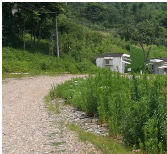
施工道路（中度）
